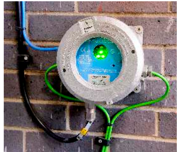
5. Le Earth Rite RTR indique que la mise à la terre est réalisée.
